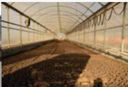
*secadero solar (EMA). Área del secadero solar: 660 m 2 /u (2u)
